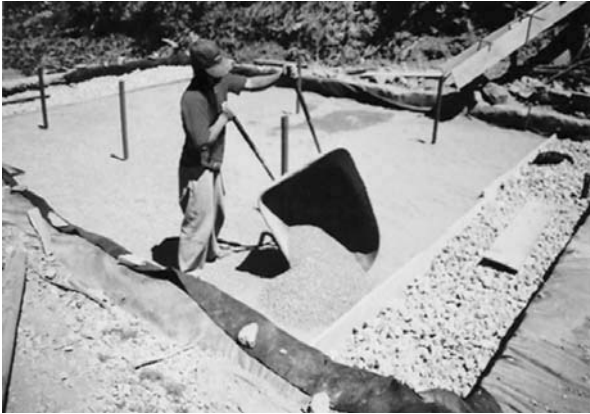
Foto 6. Colocación del medio filtrante en el humedal.
