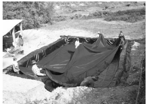
Foto 5. Colocación de la geomembrana de PVC y del geotextil.
