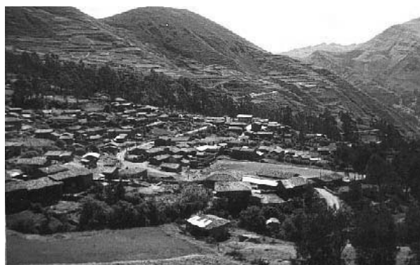
Foto 1. Vista panorámica de la comunidad urbana de Lacabamba.
