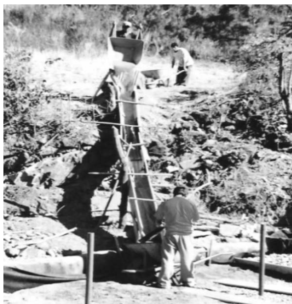
Foto 12. Comuneros participando en la construcción del humedal.
